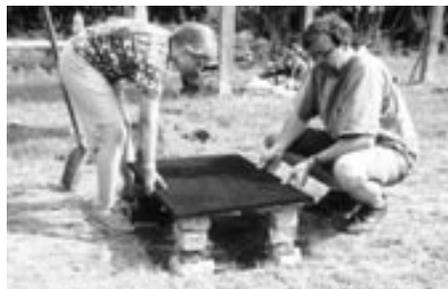
Zuerst haben wir eine Grube ausgehoben, an den 4 Ecken Steinsäulen errichtet und einen Eisenrost draufgelegt
