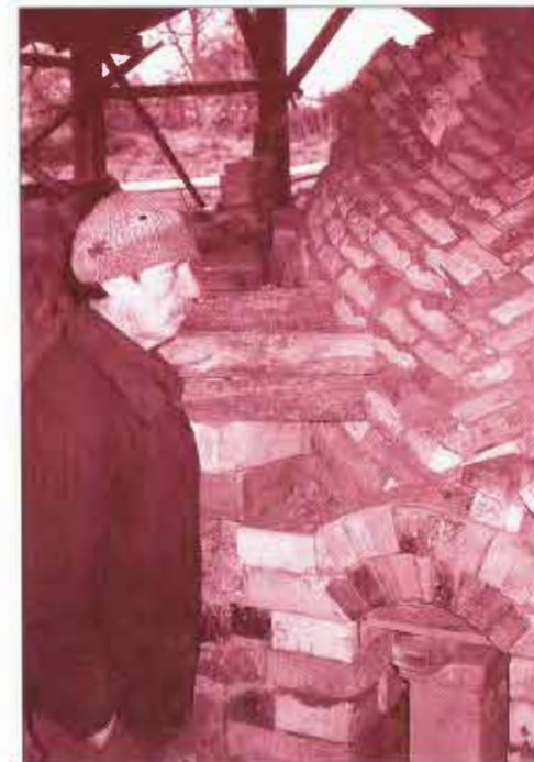
Claude Varlan am neuen Ofen (im Bau)
