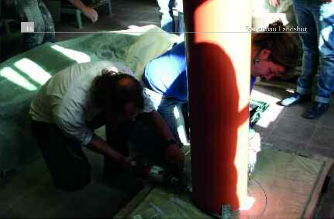
Bild oben: Das Stützrohr für den Kopf wird befestigt
